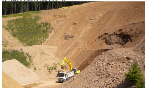
(la foto evidenzia lo scavo sull'ultimo gradone dopo aver riprofilato quelli superiori; la nicchia che si è formata al centro del penultimo gradone coincide con la presenza di piccole lenti di materiali cementato che in ogni caso non compromette la stabilità della scarpata il cui angolo complessivo viene in ogni caso mantenuto inferiore ai 45°)
